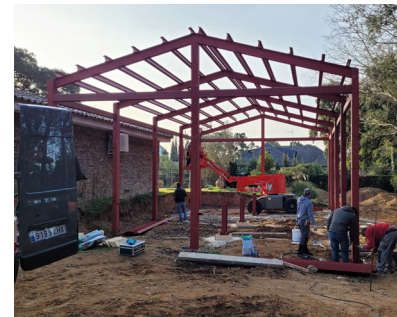
Inici de les obres del Centre Ocupacional.
